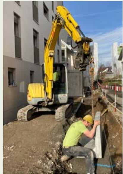
Deutlicher Zeitgewinn beim Versetzen mit Kugelkopfanke im Vergleich zum herkömmlichen System mit Winkelschlaufen. Die Elemente werden schneller, sicher und einfach im Balancepunkt versetzt.
