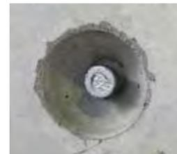
Kugelkopfanker sind in jedem Winkelplatten duplex Element integriert.
