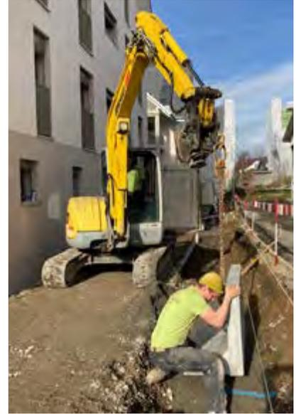
Deutlicher Zeitgewinn beim Versetzen mit Kugelkopfanker im Vergleich zum herkömmlichen System mit Winkelschlaufen. Die Elemente werden schneller, sicher und einfach im Balancepunkt versetzt.
