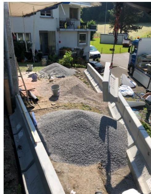
**WENNS AUF DER BAUSTELLE MAL WIEDER SCHNELL GEHEN MUSS UND DIE SICHERHEIT DABEI NICHT ZU KURZ KOMMEN DARF: WINKELPLATTEN DUPLEX SIND DANK DEM PRAKTISCHEN KUGELKOPFANKER CA. 25-30 % SCHNELLER VERSETZT (UND SICHERER!) ALS MAUERSCHEIBEN MIT WINKELSCHLAUFEN.**
