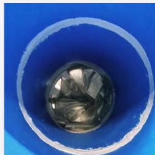
Überschüssige Dichtmasse mittels Spachtel gleichmäßig verteilen, um eine ebene, rückstandslose Oberfläche zu erhalten.
