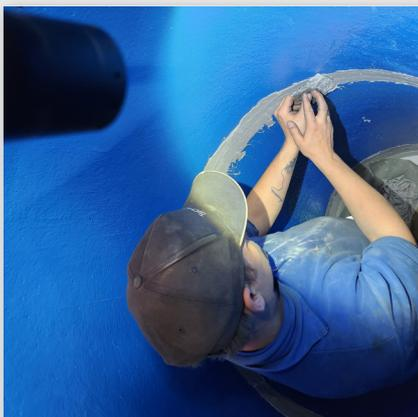
Die überschüssige Dichtmasse mittels Spachtel gleichmässig verteilen, um eine ebene, rückstandslose Oberfläche zu erhalten.
