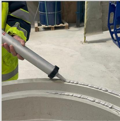
Vor dem Aufeinanderstellen den Falz mittels mitgelieferter Dichtmasse in zwei Bahnen abdichten. Wichtig: Die Wulst ist wie auf dem Bild angeordnet auszuführen. Aufgrund der Aushärtung immer nur den jeweiligen Falz abdichten. Bedarf: 1 Tube pro Falz.
