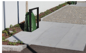
Abdeckung aus Betonplattenelementen
