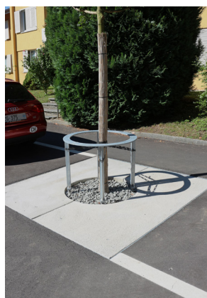
Abdeckung aus Beton-Halbplatten
