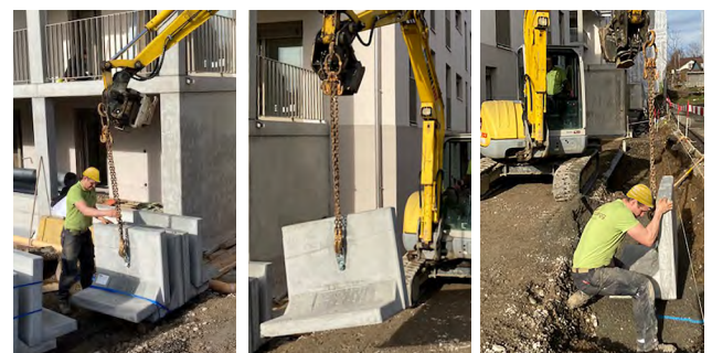
Deutlicher Zeitgewinn durch das Versetzen mit Kugelkopfancker.
